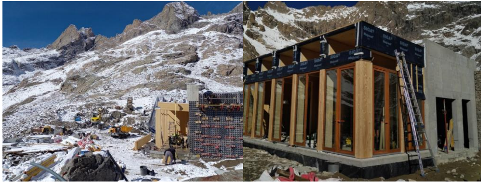
Photo A : : Travaux du nouveau refuge du Pavé ( https://www.laraboterie.com/ - https://geoprocess.fr/ )
