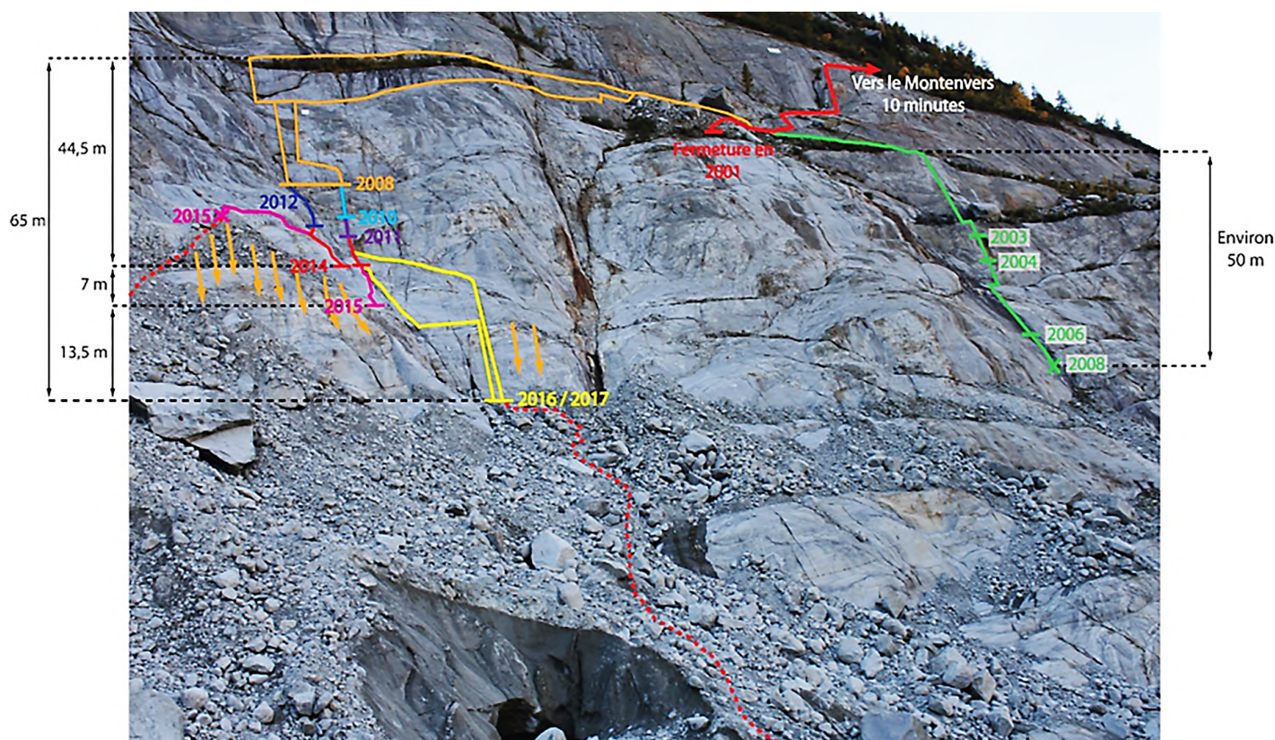
Figure 2 : Évolution de l'accès à la Mer de Glace depuis le site touristique du Montenvers. Entre 2001 et 2017, environ 80 m de dénivelé d'échelle ont été ajoutés (Mourey et Ravanel, 2017).
