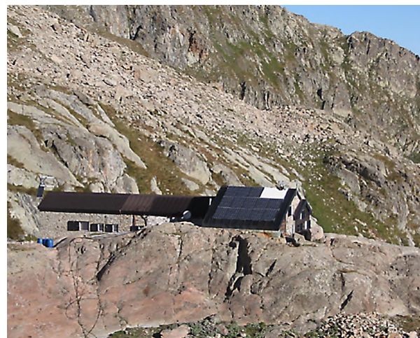
Image 2 : le refuge Pagari après des travaux d'adaptations
