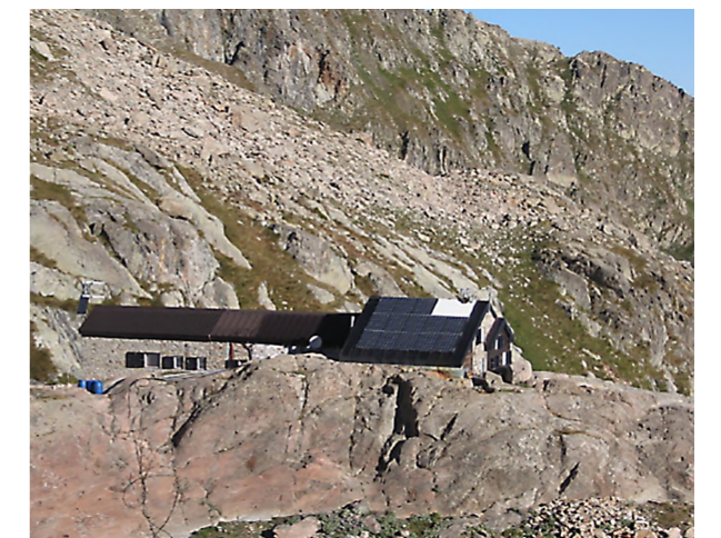
Image 2 : le refuge Pagari après des travaux d'adaptations
