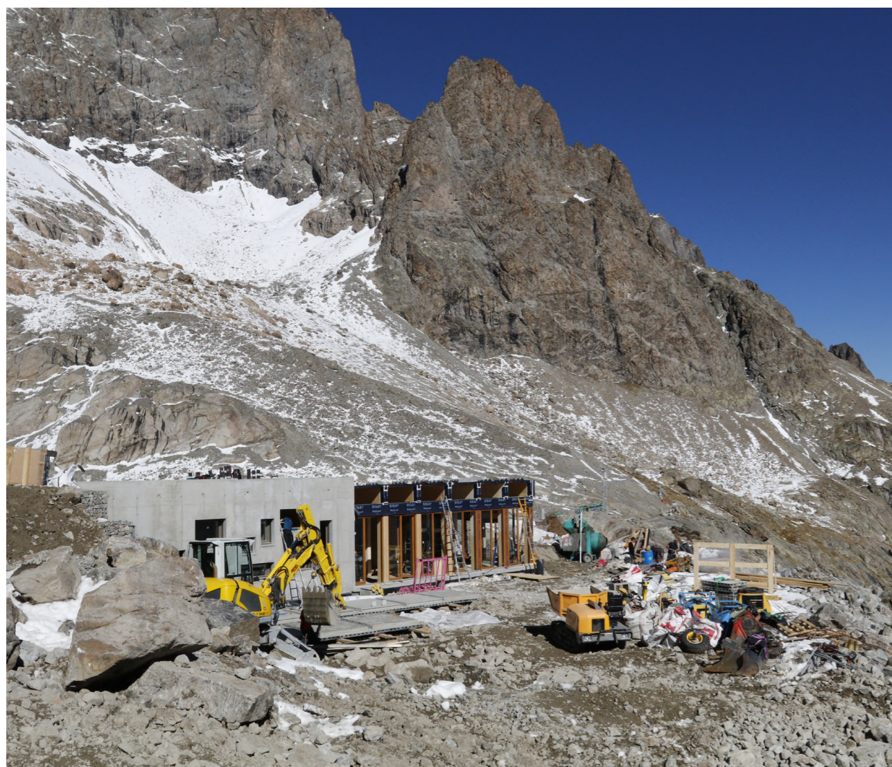
Construction du nouveau refuge du Pavé en 2022
