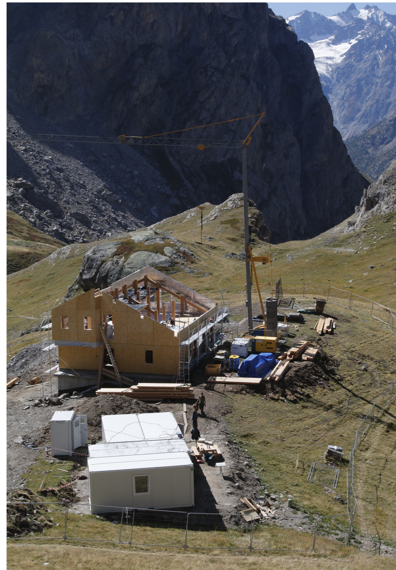
Construction du refuge du Clot des Vaches
