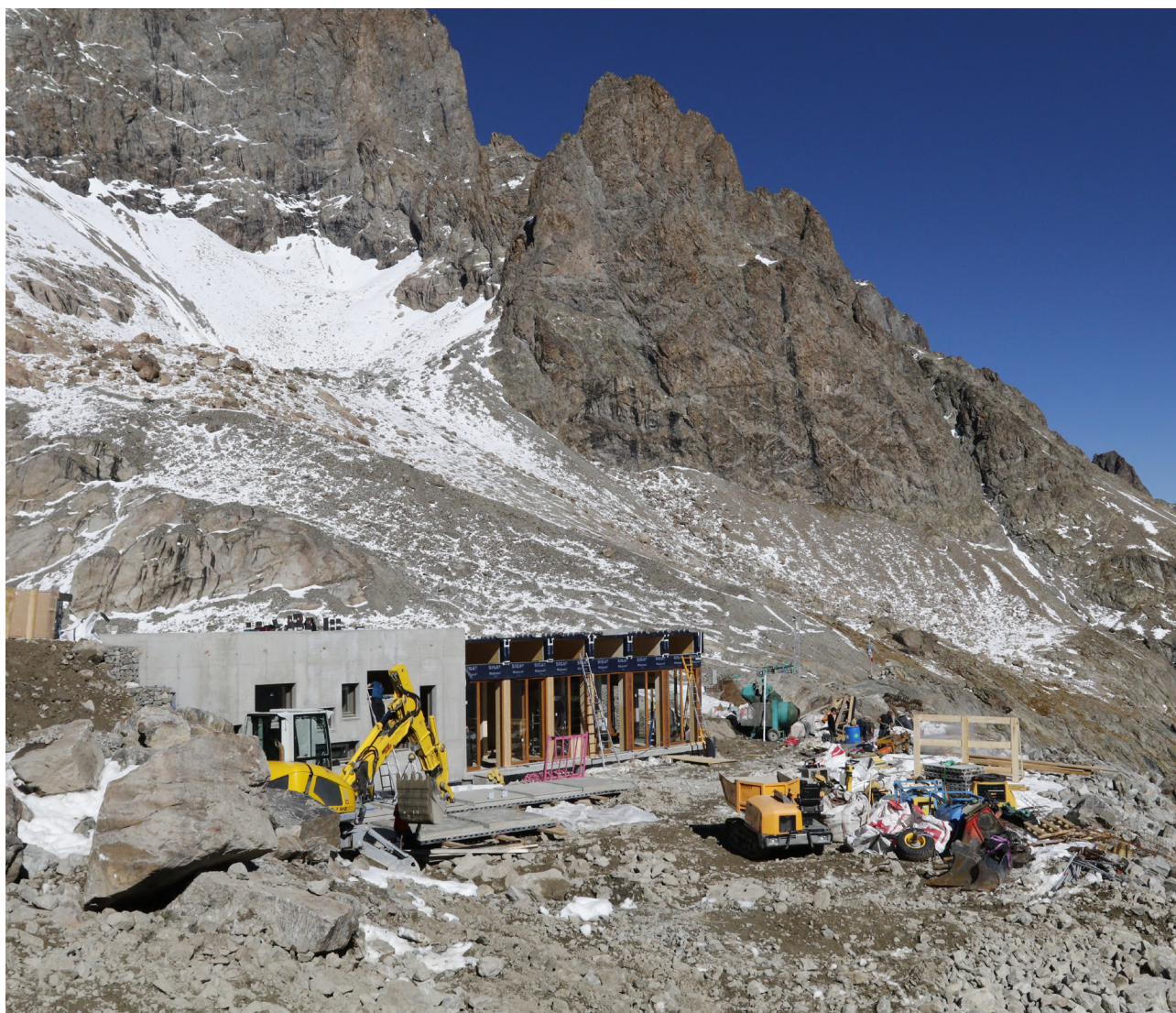
Construction du nouveau refuge du Pavé en 2022
