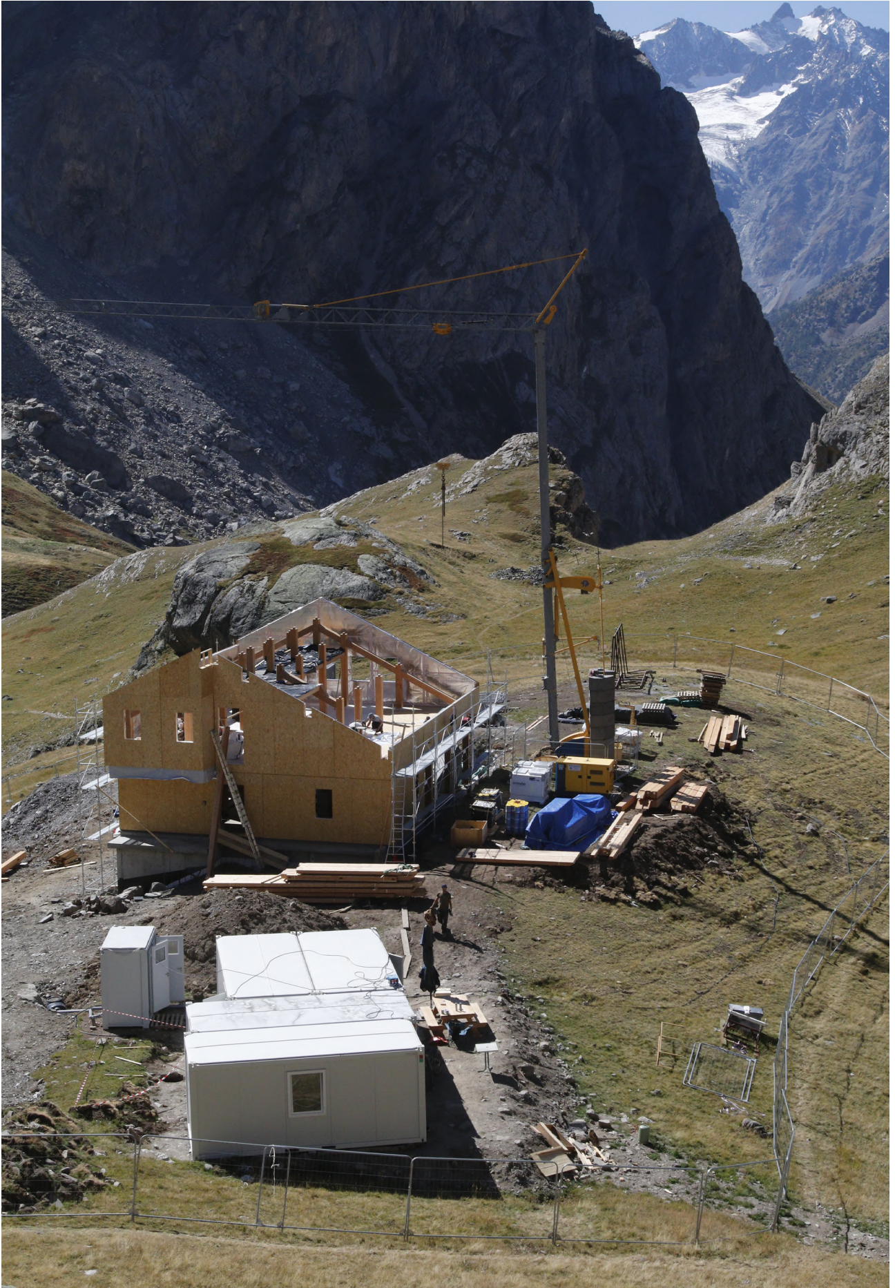
Construction du refuge du Clot des Vaches
