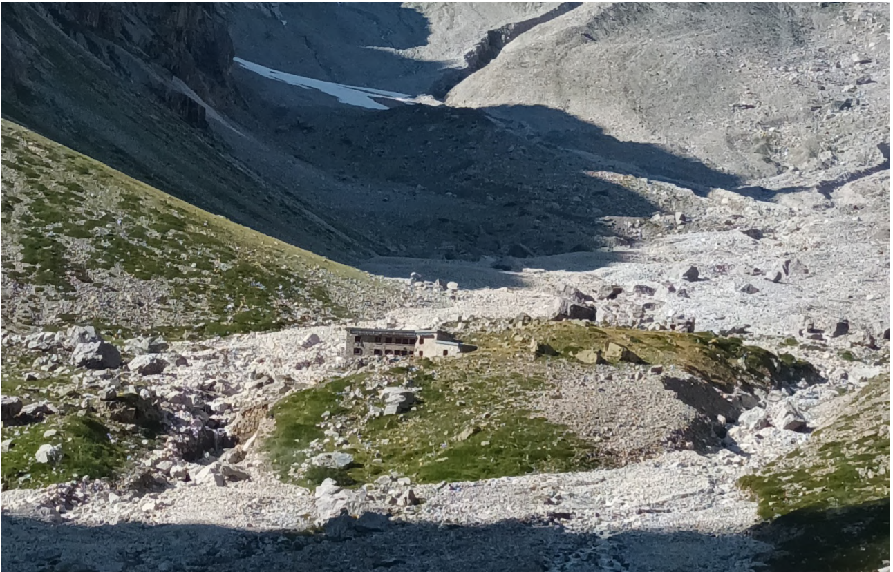
La moraine impactée par les orages du 29 juillet 2022 au-dessus du refuge du Châtelleret ©P-H. Peyret - Parc national des Écrins
