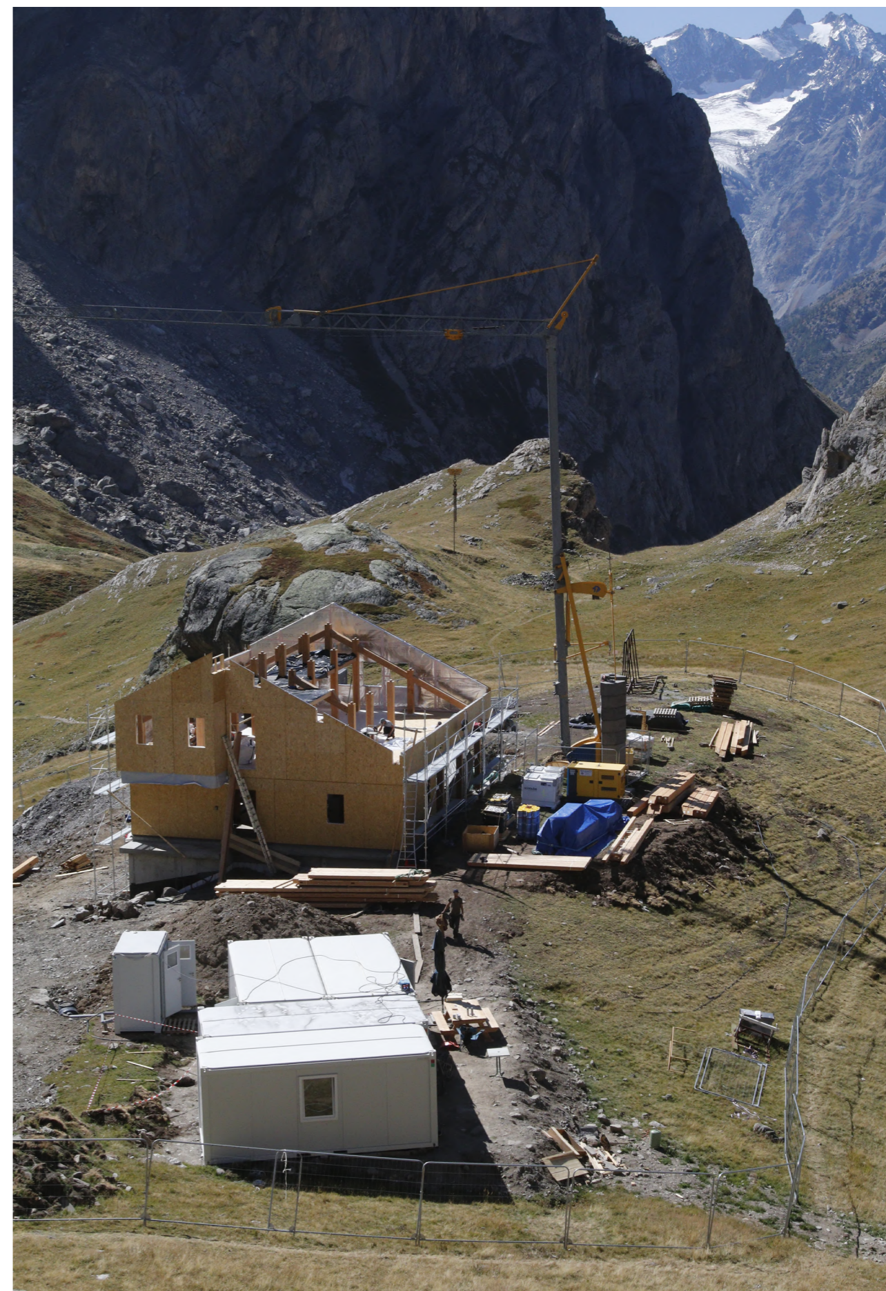
Construction du refuge du Clot des Vaches
