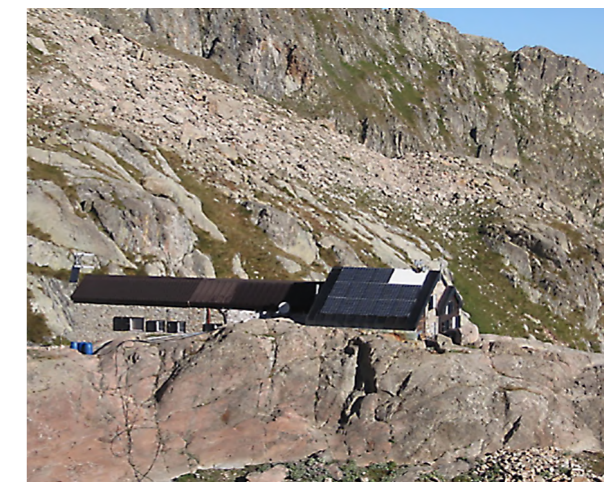
Image 2 : le refuge Pagari après des travaux d'adaptations
