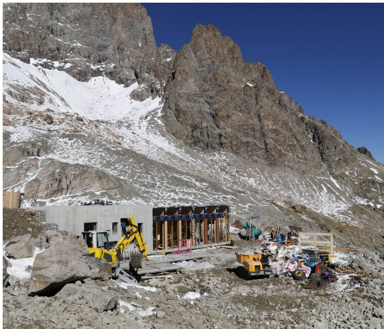
Construction du nouveau refuge du Pavé en 2022
