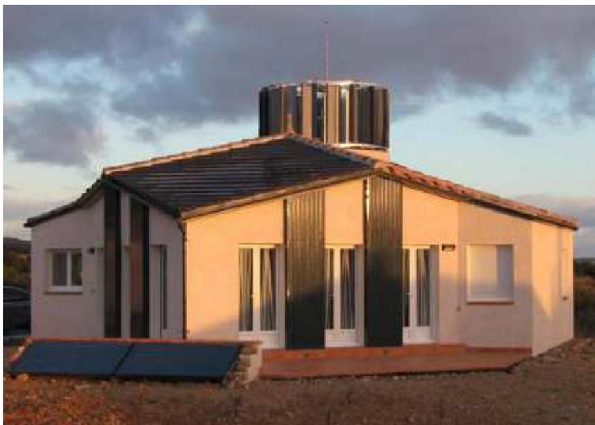
**Figure 12.- L'implantation du Stator sur une maison individuelle.**
