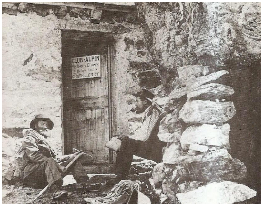
Figure 3. L'ancien refuge du Châtelleret, implanté en pierres en 1882 par la Section de l'Isère du Club Alpin sous une dalle. Source : Centre de documentation Lucien Devies. FFCAM.
