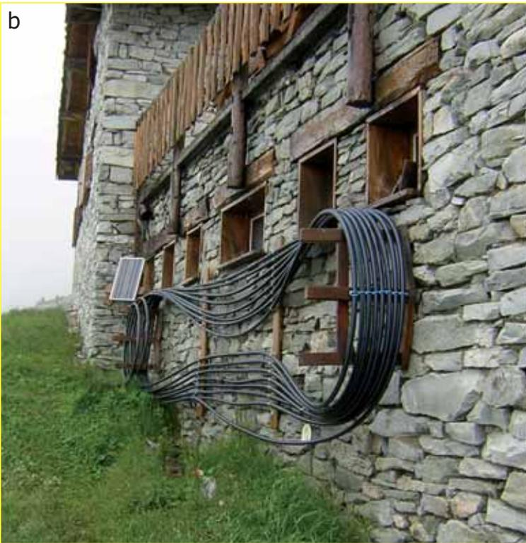
Figure 4 : Capteurs solaires thermiques basiques en Piémont (a) et Vanoise (b) (Plan Sec).
