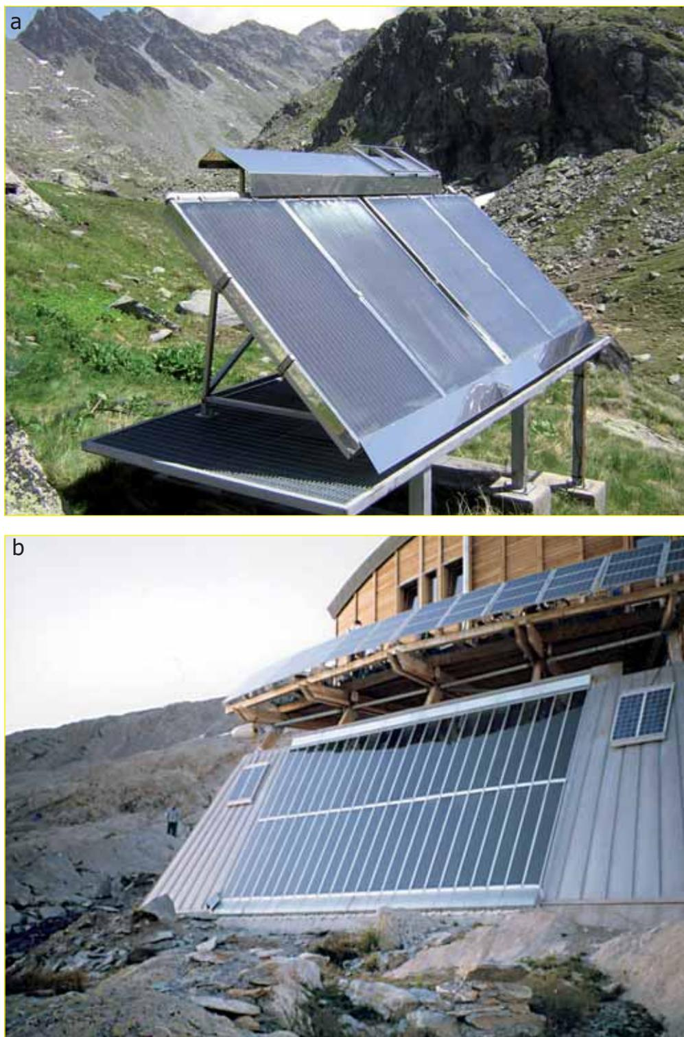
*Figure 6 : Chauffage solaire pour le traitement des eaux usées aux refuges Deffeyes, Val d'Aoste (a) et des Conscrits, Mont Blanc (b).*
