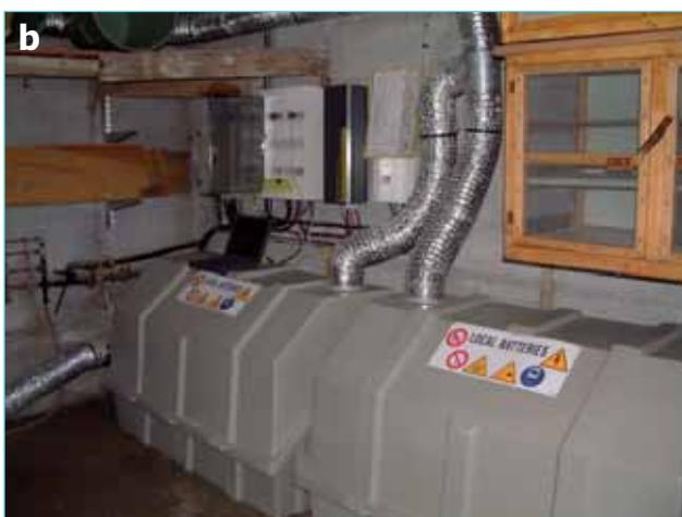
Figure 9: a, Local des batteries - refuge Quintino Sella al Sèlik (60 batteries de 250 Ah, Onduleur 3kVA) et b, Vallonbrun (photo PNV).
