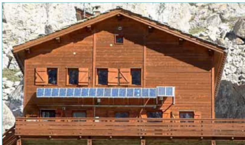
Figure 10: Extension de l'installation photovoltaïque du refuge de la Femma -Vanoise (photos PNV).
