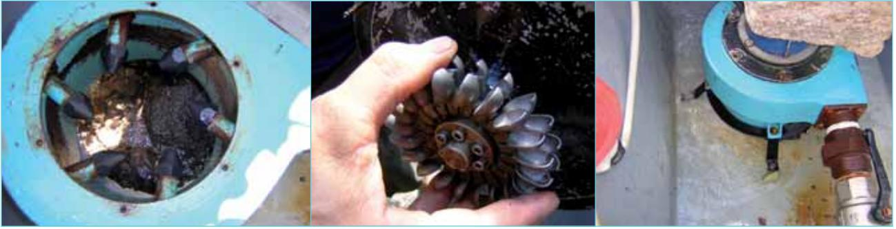
Figure 11 : Micro centrale à roue Pelton du refuge Levi Molinari (Piémont).
