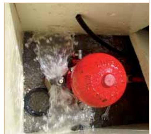
Figure 19 : Schéma de principe et photo du béliet hydraulique du refuge de Pisset - Beaufortain (photo P. Mandaroux, schéma [www. Walton.fr](http://www.walton.fr)).
