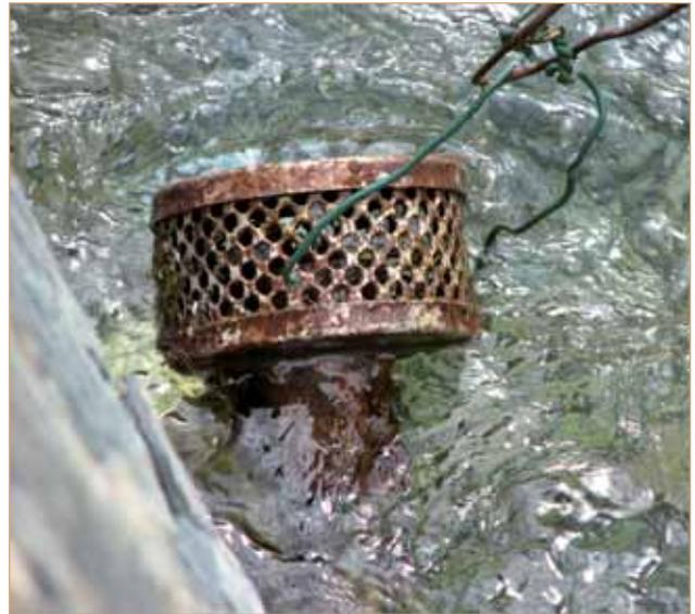
Figure 16 : Crépine de prélèvement (photo S. Pelisset).
