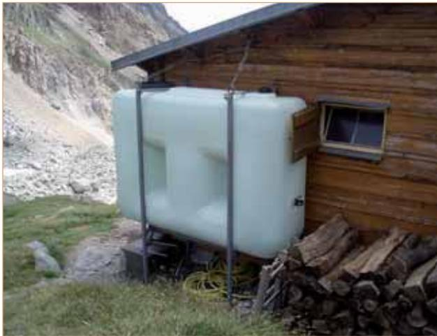
Figure 25 : Réservoir extérieur d'eau potable refuge de Preset - Beaufortain (photo P. Mandaroux).
