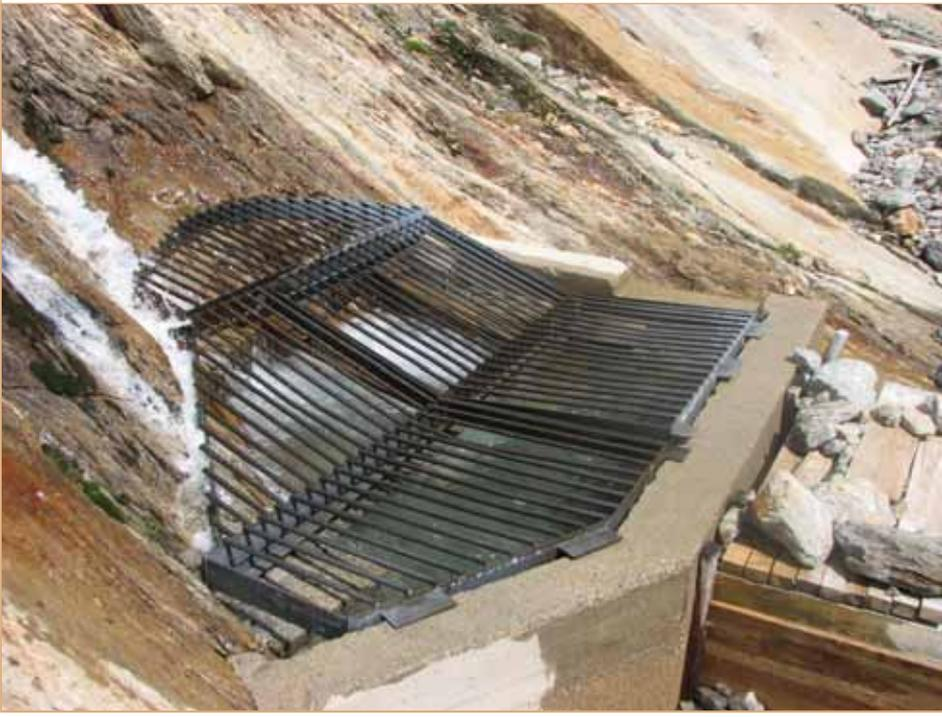
Figure 14 : Schéma et photo d'une grille de prélèvement, refuge des Conscrits – Mont Blanc (photo S. Pelisset).
