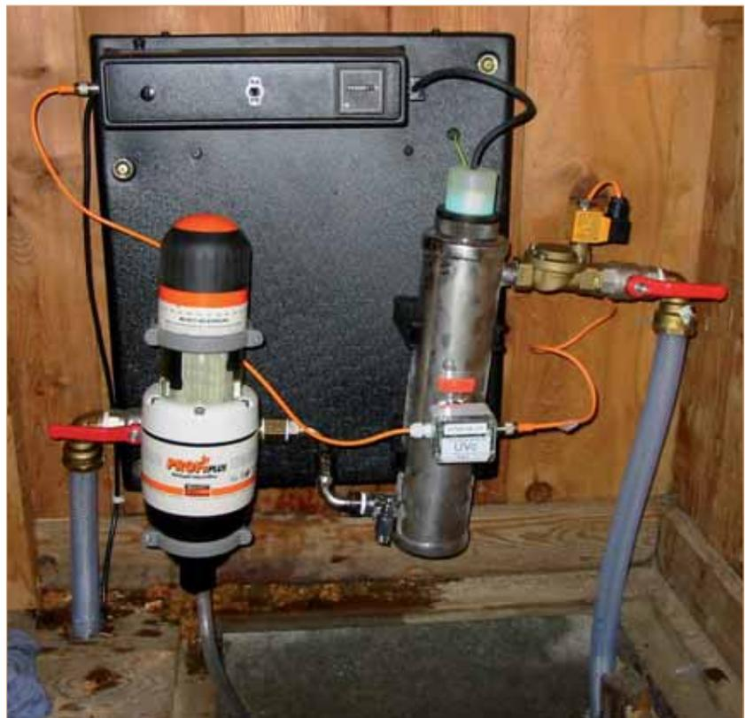
Figure 28 : Schéma de principe et photo du traitement UV au refuge de l'Arpont - Vanoise (photo PNV).
