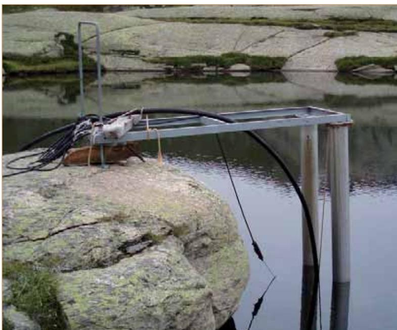
Figure 18 : Prise d'eau du refuge des Evettes - Vanoise (photo P. Mandaroux).
