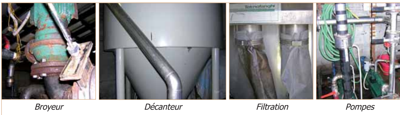
Figure 9 b : Photos de la «station d'épuration» du refuge Deffeyes (Aoste).
