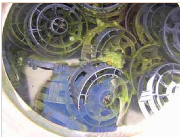
Figure 28 : Garnissage plastique neuf du lit bactérien du refuge Bertone - Aoste.
