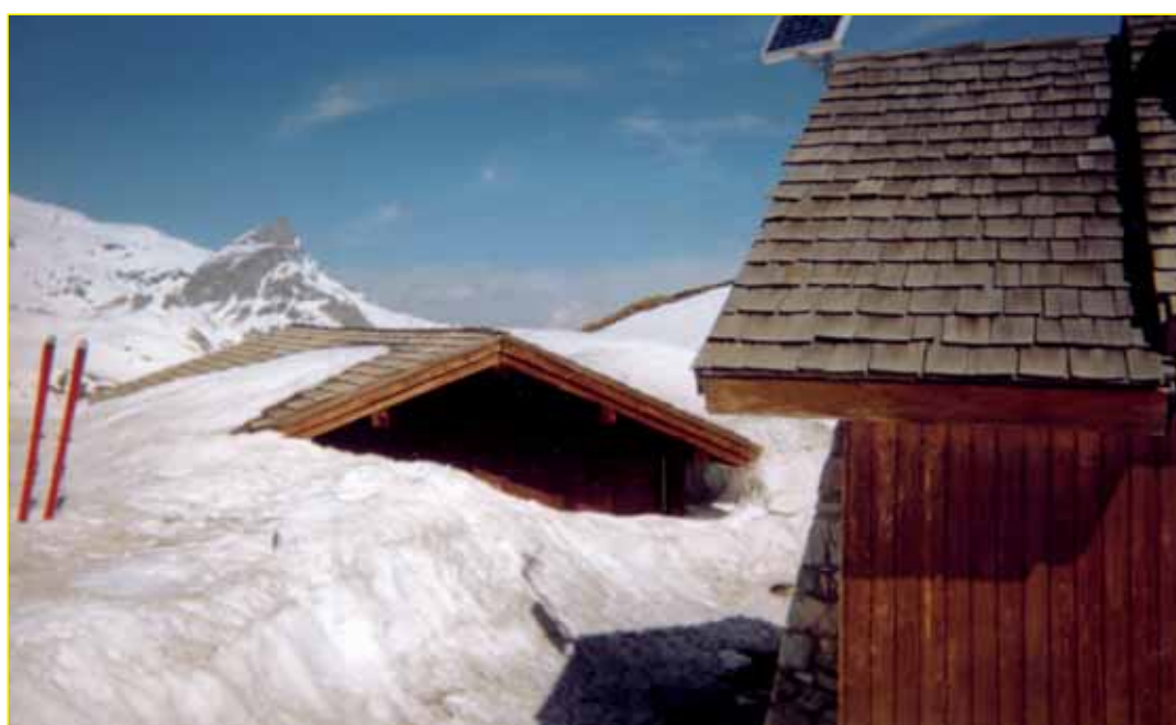
Figure 5 : Bâtiment-dortoir du Refuge du col du Palet - Vanoise.
