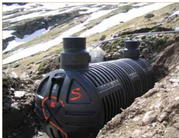
Figure 13 : Fosse toutes eaux double peau du refuge de l'Arpont (16 m 3 ) – Vanoise (photos PNV).
