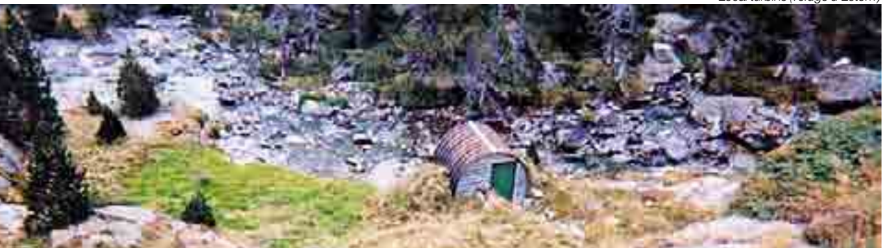
Local turbine (refuge d'Estom)
