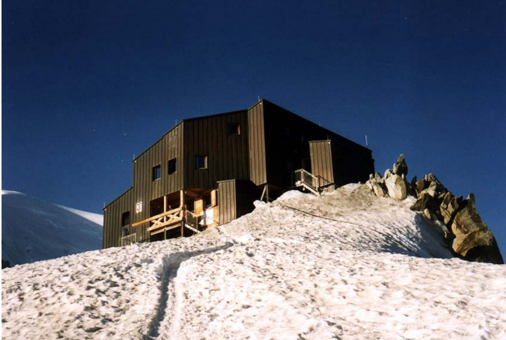
Un refuge de haute montagne par excellence (refuge des Cosmiques, Commune de Chamonix, massif du Mont-Blanc)
