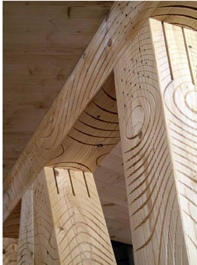
*Fig. 102. Ornements gravés numériquement sur la structure en bois de la cabane du Mont Rose.*
