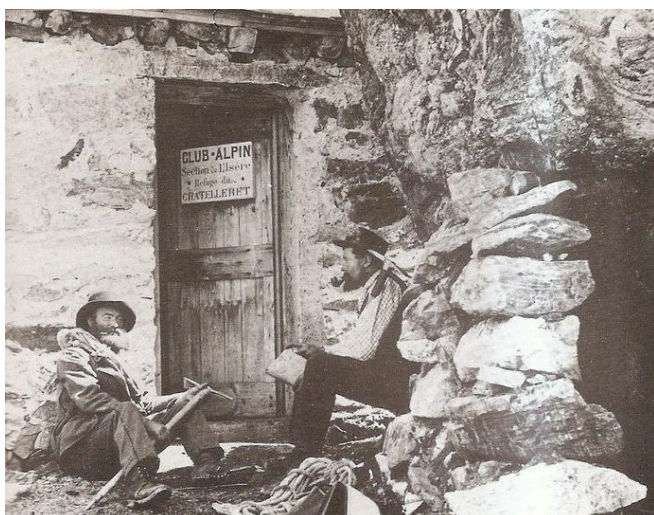
Figure 1 : Refuge-bivouac adossé à la paroi. Fonds FFCAM.
